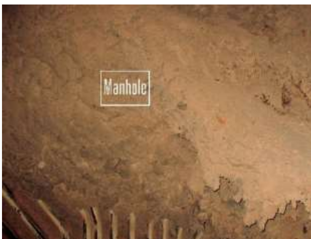
Pohled na silně znečištěné topeniště po 5 dnech provozu kotle bez úpravy.
