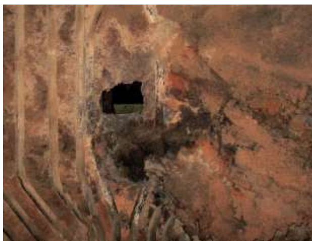
Pohled na stejnou oblast po 12 dnech provozu s dávkováním přísady PentoMag® 2550.
